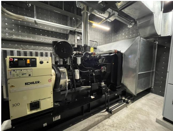
รูปที่ 2-25 จัดให้มีเครื่องกำเนิดไฟฟ้าสำรอง
